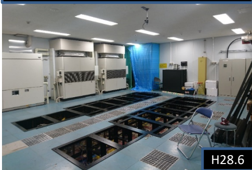
ストレージ撤去後の様子
