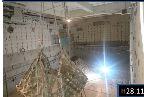
床が撤去され地下室が露出
