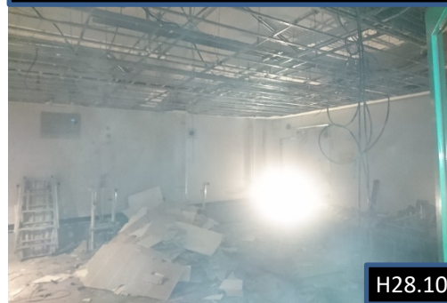
壁・天井の撤去
