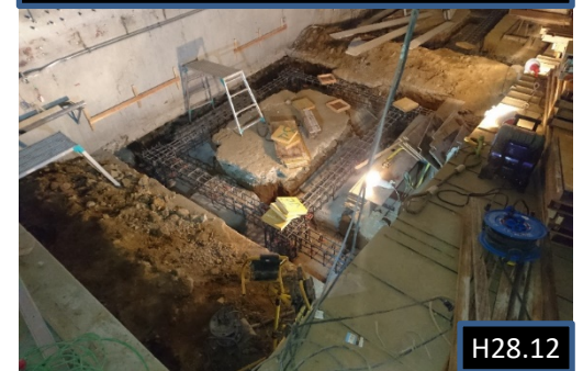
地下室の床の基礎再構築
